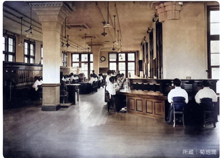
2階交換室 1926年1月（大正15）撮影
